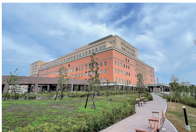
東京女子医科大学附属足立医療センター 令和3年度に江北駅付近に開院
