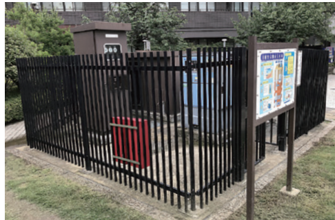
日暮里公園永久水利・深井戸方式
