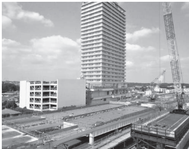
高架化工事が進む東村山駅周辺の様子
