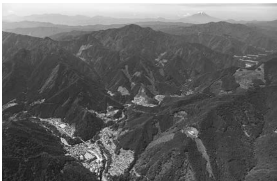
奥多摩町（奥多摩町全景）
