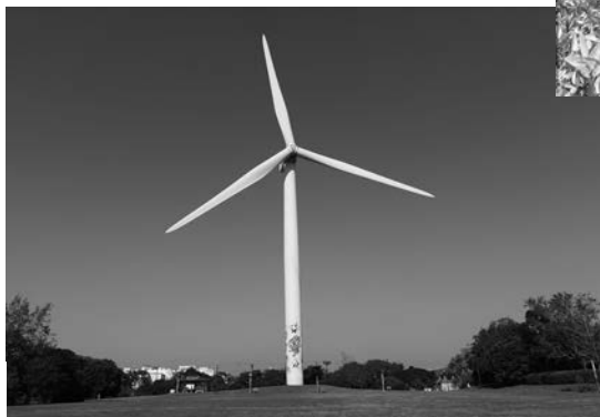
若洲風力発電施設
