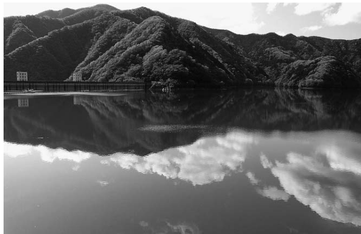
小河内ダム（奥多摩湖） 東京都の貴重な水源である奥多摩湖は、総貯水量約1億8000万トン、都民が利用する水の約2割を供給しています。木々や周囲の山稜を映す湖面は静寂に満ち、新緑、紅葉、冬木立が四季を鮮やかに演出します。
