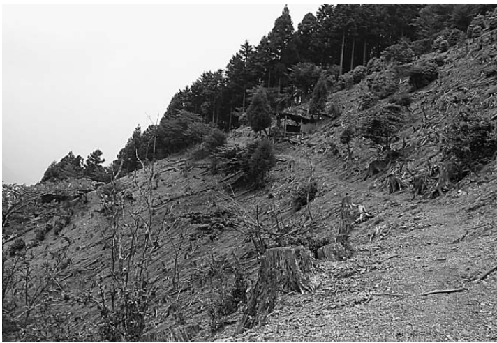
森林崩壊地 伐採跡地の植苗が、鹿の食害により生長することができず、また、鹿が歩くことにより、地面が踏み固められて草も生えず、森林一帯が砂漠のようになってしまいます。通常森林には、雨を徐々に地中に浸透させる機能、保水する機能、草木の根により土を抑える機能がありますが、砂漠化の森林では、雨が地中に浸透せず、表面の土が谷に流れ込み濁流となります。このような場所が数か所確認され、町営水道の取水口の土流でも被害が発生しました。
